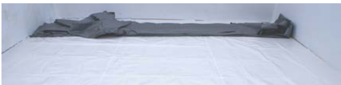
Abbildung 33 – Entfalten der Folienauskleidung
