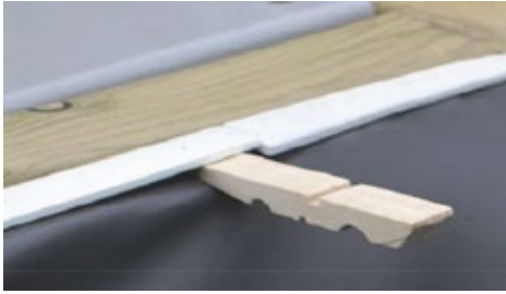
Abbildung 32 – Verkeilung der Folienauskleidung mithilfe der halben Wäscheklammern
