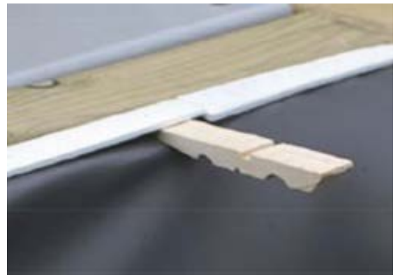
Abbildung 33 – Verlegung der Folienauskleidung mithilfe der halben Wäscheklammern
