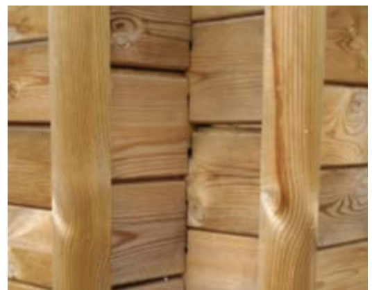
Abbildung 62 – Ineinanderfügen der Holzbohlen
