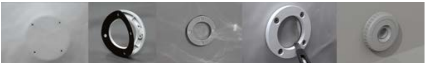
Abbildung 36 – Anbringen des Flansches am Rücklauf
