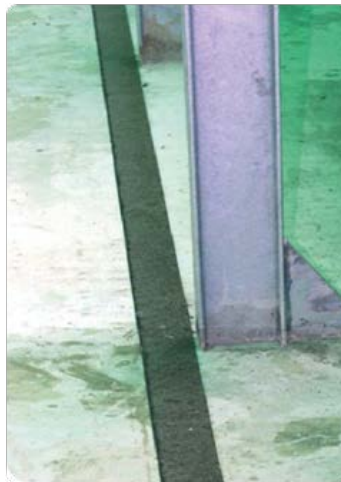
Abbildung 9 – Anbringen der Bitumenstreifen
