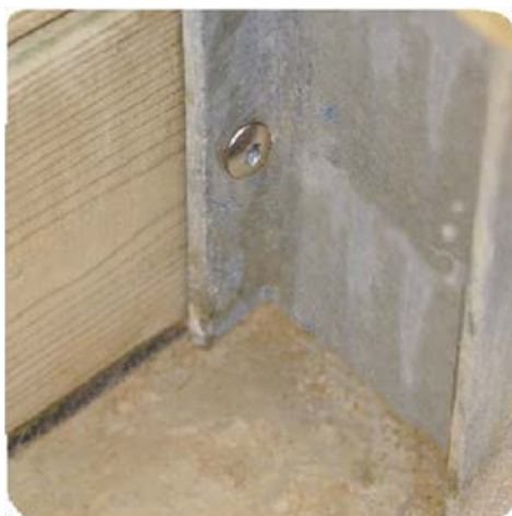
Abbildung 13 – Verkantung der Bohlen auf den Streben
