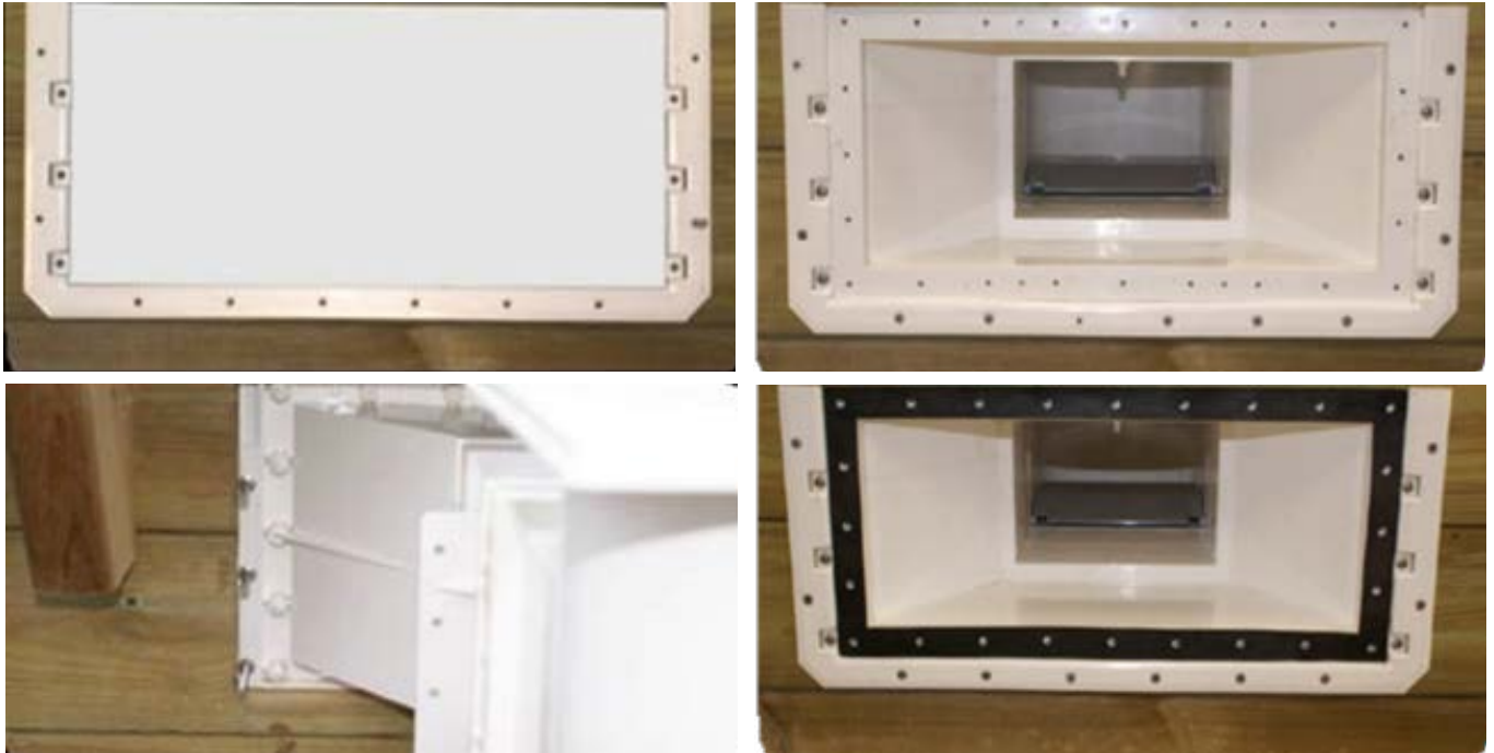
Abbildung 24 – Montage des Skimmers
