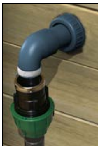
Abbildung 45 – Starr abfallendes Rohr des Reinigungsanschlusses und starr abfallendes Rohr der Einlaufdüse (Odyssea-Modellèle Odyssea)
