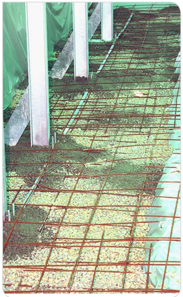
Abbildung 10 – Giessen des Betonplatte (b)
