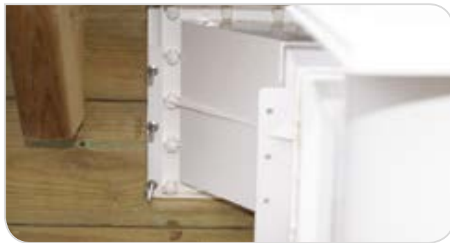
Abbildung 34 – Befestigung des Skimmers
