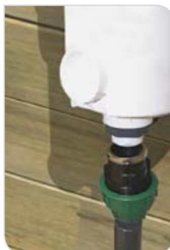
Abbildung 44 – Anschluss des Skimmers
