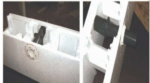
Symbolfotos „Einbau der Mauerdurchführung mit Loch- und Stichbohr“
