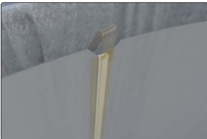
Scharfe Kante mit Klebeband abkleben
