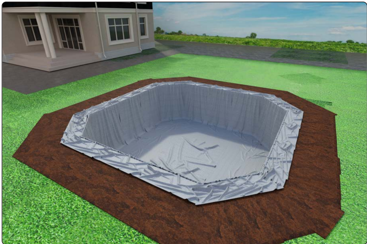
Geotextvlies vollflächig ausgelegt
