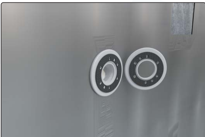
Dichtungsscheiben aufkleben
