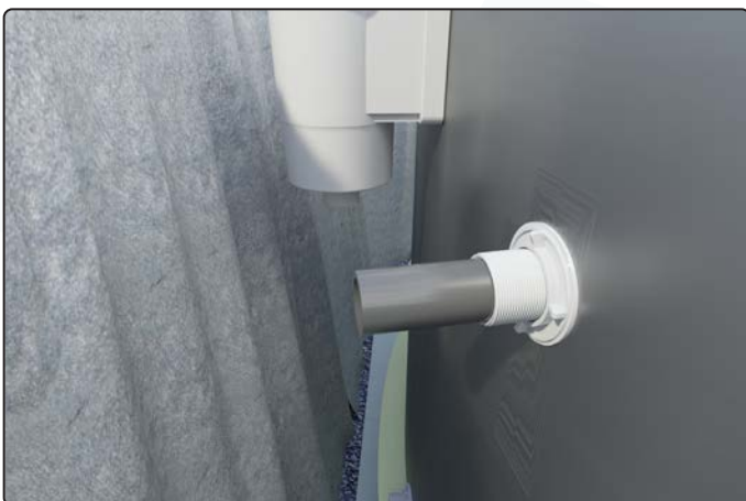
Rückseite Stahlwand: 13cm PVC Stützen einkleben
