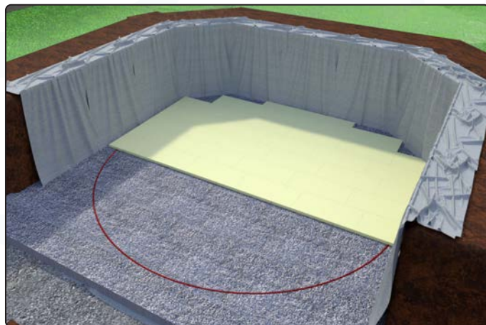
Bodenplatten mit Gesamtüberstand 30cm verlegen
