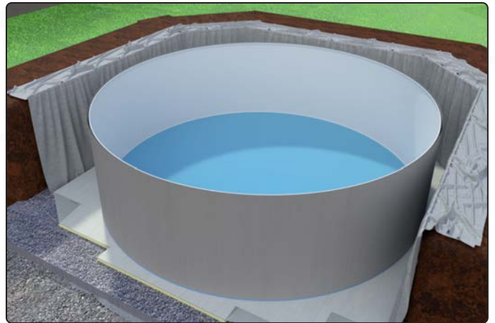
ca. 3mm Wasser einfüllen, Bodenfallen glätten
