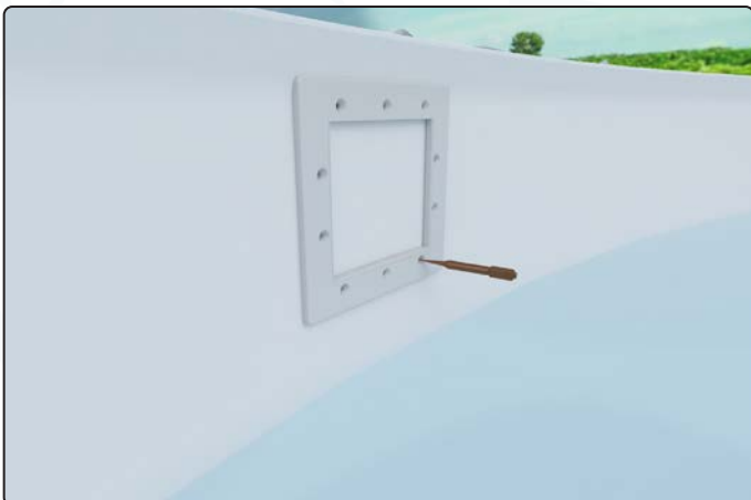
Lochbild nach Innenflansch anzeichnen und vorstechen
