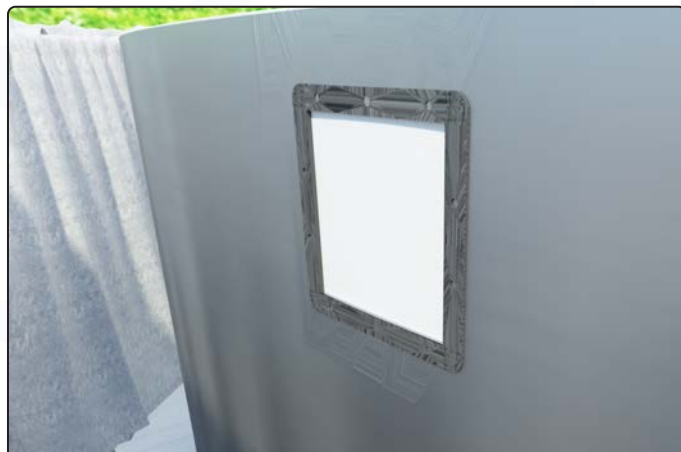
Doppeldichtung auf die Skimmeröffnung stecken
