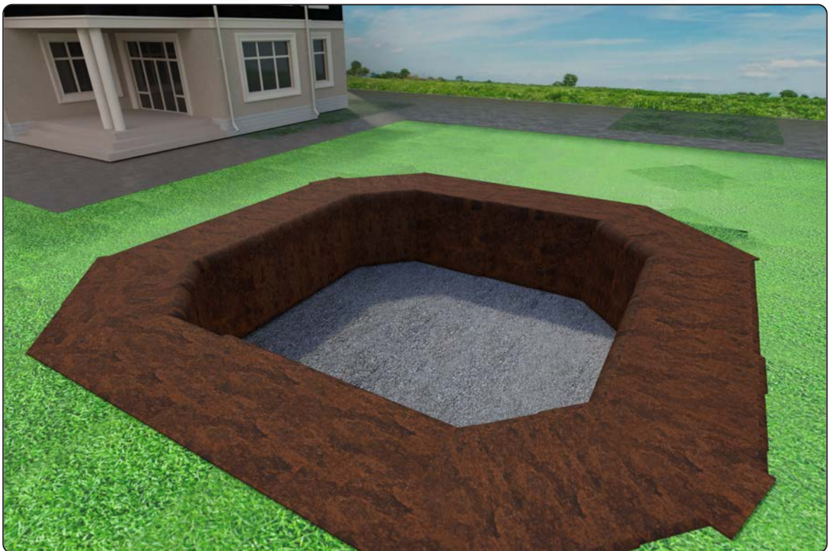
Falls erforderlich: Baugrube mit zusätzlicher SchotterSchicht
