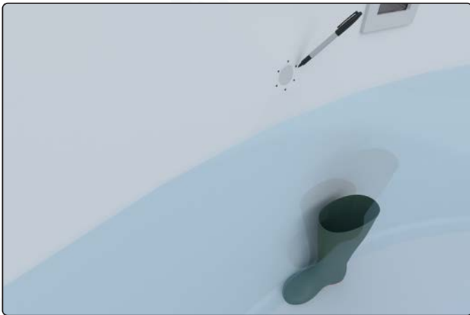
Mit Fuß die Folie in der Kehle vorspannen, Gewindelöcher Einlaufdüse anzeichnen und vorstechen
