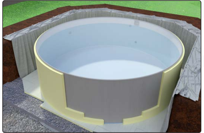
Rundschalung zusammenstecken. 15cm Elemente unten
